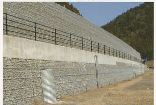
高知県 / 国道 439 号線
