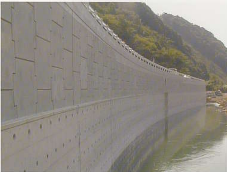
宮崎県 / 国道 388号 総壁面積 2,480m 2 壁高 11.25m
