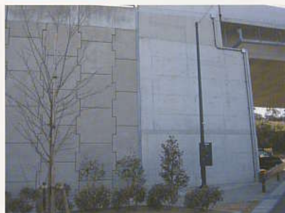
橋台との取合い
