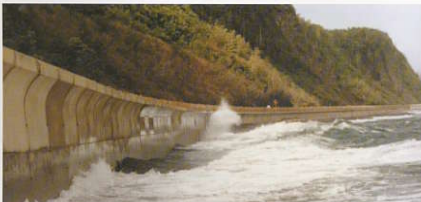
カナダ / Carleton Seawall 総壁面積 55,000m 2 延長 13.1km
