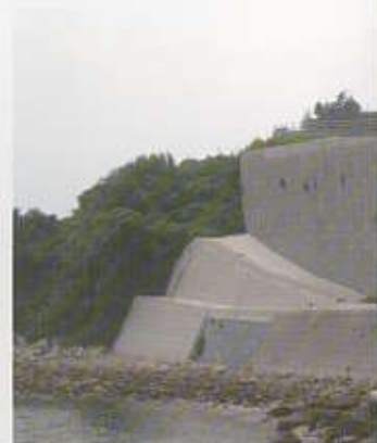
広島県 / 県道上蒲刈島循環線
