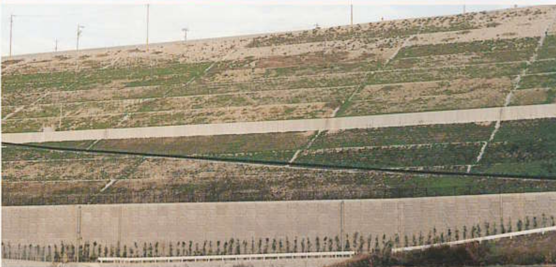
広島県 / グリューネン入野造成 上載盛土12段 法勾配1:1.8 全高60m 総壁面積 10,109m 2 壁高 15.75m
