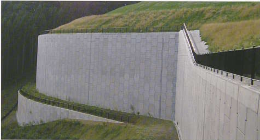
青森県 / 青森空港造成工事 総壁面積 3,195m 2 壁高 29.25m
