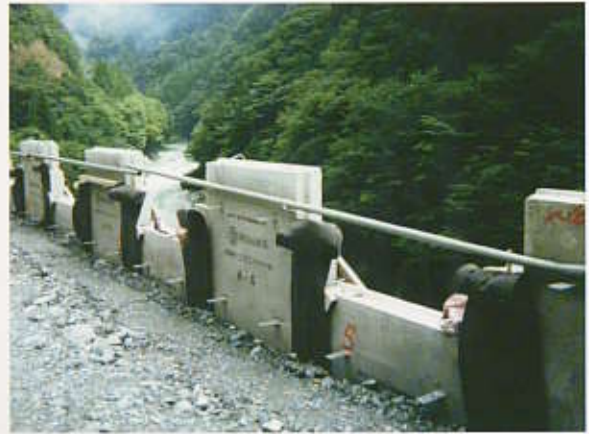
転落防止(施工時)
