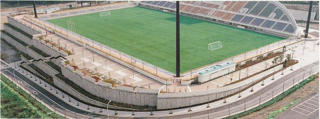
静岡県 / 日本平運動公園造成工事(清水エスパルス本拠地・3段積) 総壁面積 4,699m 2 合計壁高 15.75m
