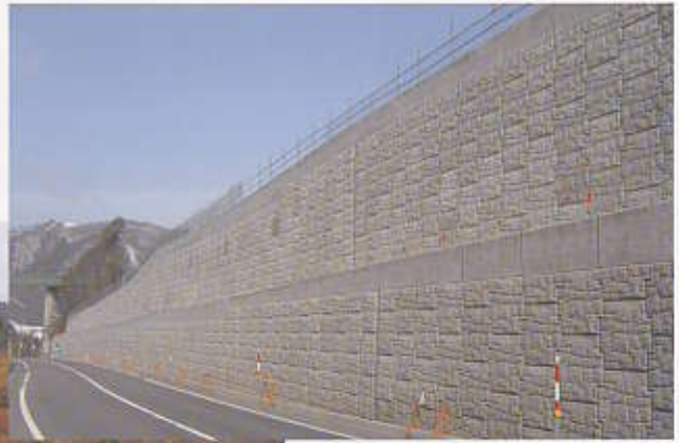
岐阜県 / 中部縦貫自動車道 総壁面積 3,575m 2 合計壁高 19.5m
