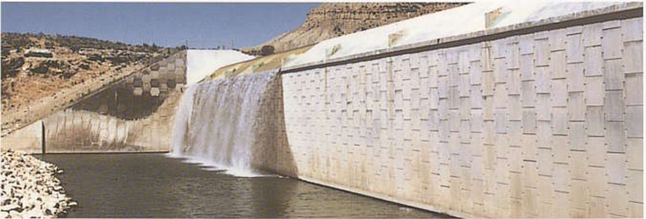
〈放出量 1,850m 3 /s を有するダム堤体〉
