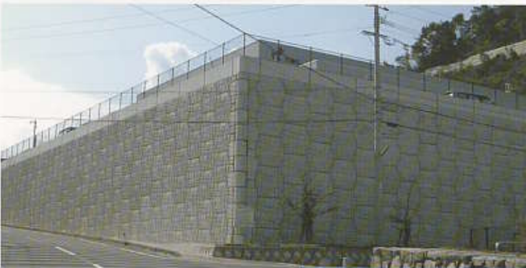
福岡県 / 民間造成 壁面積 1,132m 2 壁高 9.0m
