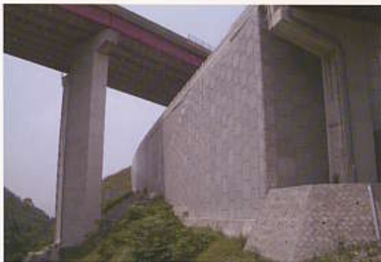
EPSと併用した複合橋台の事例
