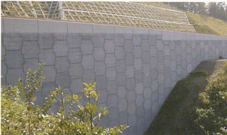
鳥根県 / 江津道路(上條西地区) 壁面積 669m 2 壁高 14.25m
