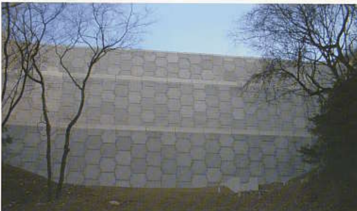
岡山県 / 広域農道備前東部地区 総壁面積 1,324m 2 合計壁高 22.5m
