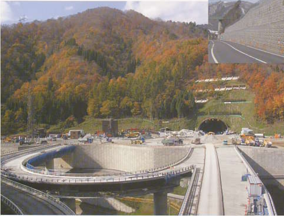
岐阜県 / 東海北陸自動車道 総壁面積 3,405m 2 合計壁高 19.5m
