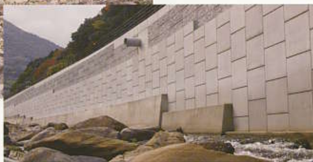
国土交通省中国地方整備局 国道9号線津和野川左岸工事
