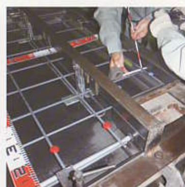
配筋検査状況
