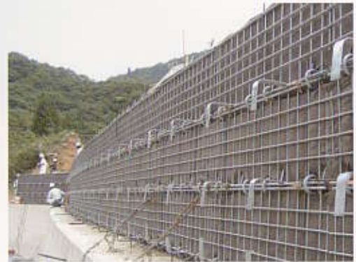
メッシュパネル組立て状況
